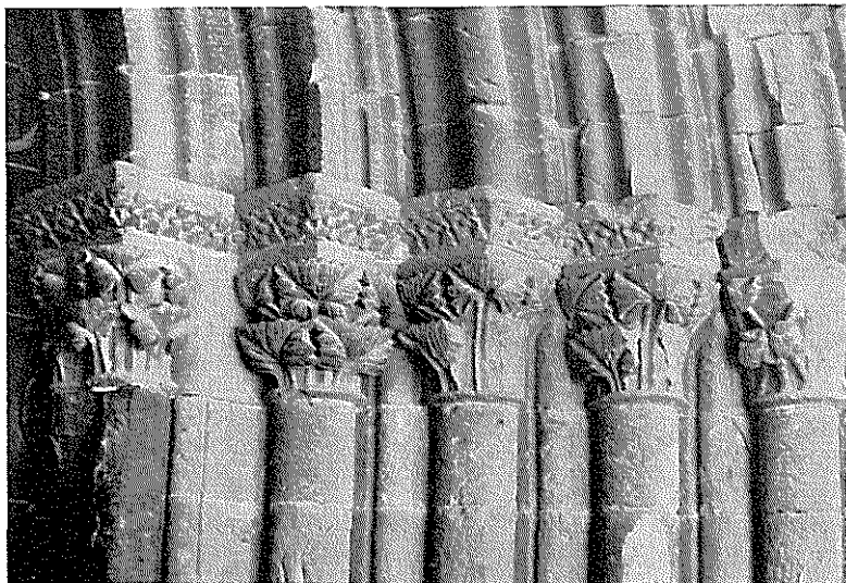
Lám. 39.—Muro de Agreda: Iglesia de San Pedro.
