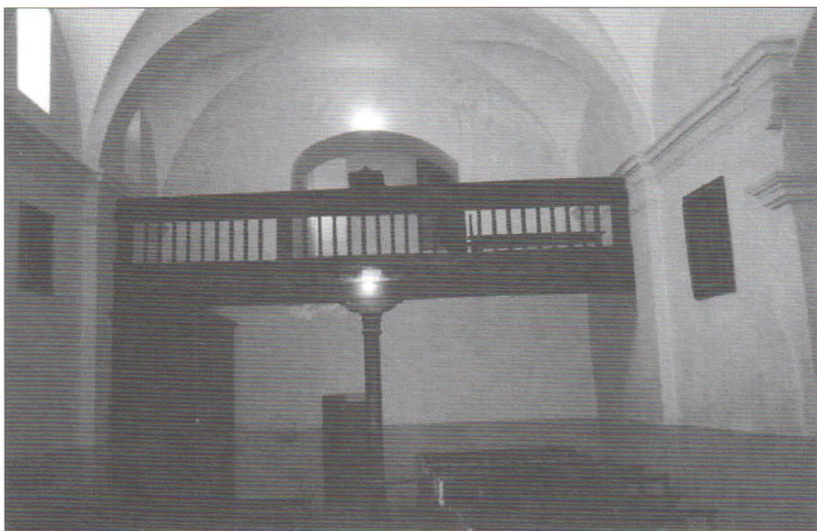
Coro con barandado de madera y puerta de entrada a la izquierda.
