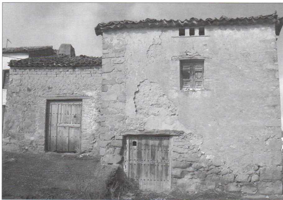
Casa tradicional de Ledesma. Se pueden observar los elementos típicos empleados para su construcción.
