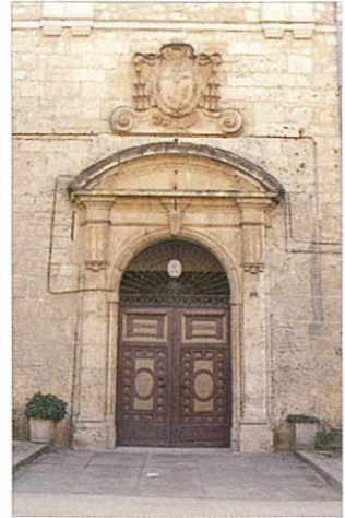
Imagen: Detalle de la puerta de acceso al Seminario y del cuerpo central en su conjunto
