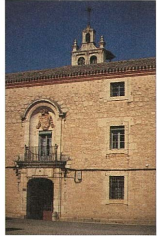
Imagen: Colocación y detalle de la espadaña del Hospicio de San José.
