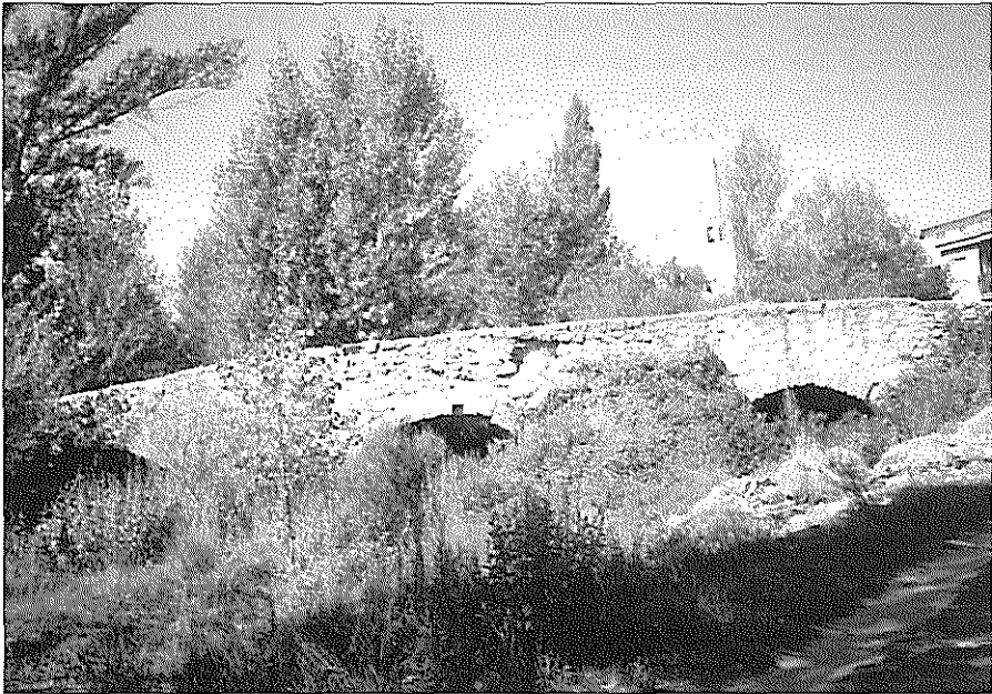
CORUÑA DEL CONDE: puente romano sobre el río Arandilla; al fondo las ruinas del castillo.
