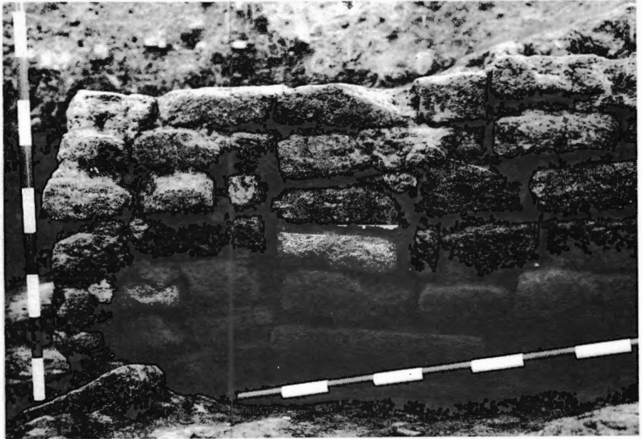
Lám. II.—Fotografía superior, detalle constructivo en la roca junto al registro número 1. Fotografía inferior, muro de adobes hallado en el límite oriental de la Casa del Acueducto. (Fotografías José Luis Argente)
