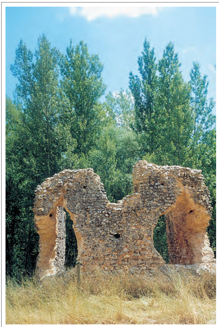
Vista del casi derruido sepulcro turriforme.
