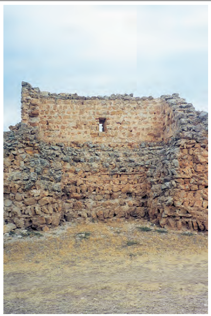
Torre semiderruida en la parte norte del albacar de la fortaleza califal.
