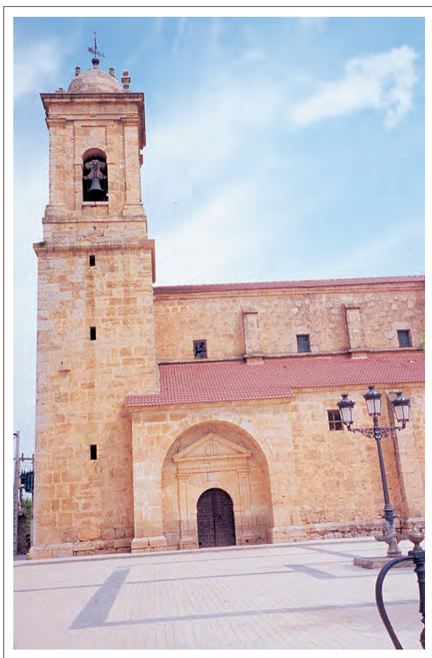
Torre campanario y parte de la iglesia con la entrada principal en el pueblo de Recuerda.
