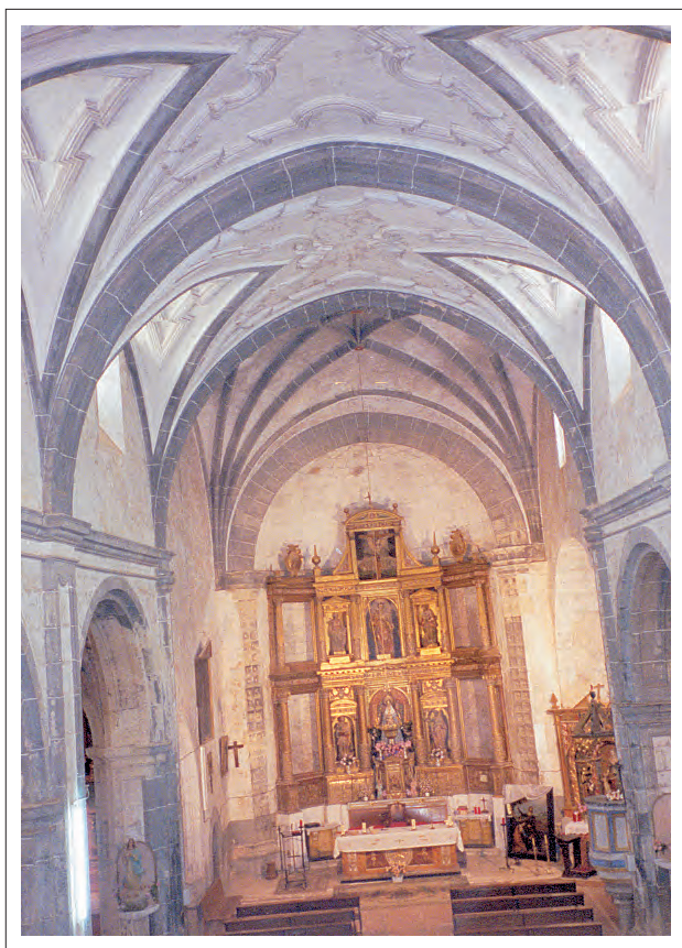
Arcos y bóvedas en el interior de la iglesia del pueblo de Recuerda.
