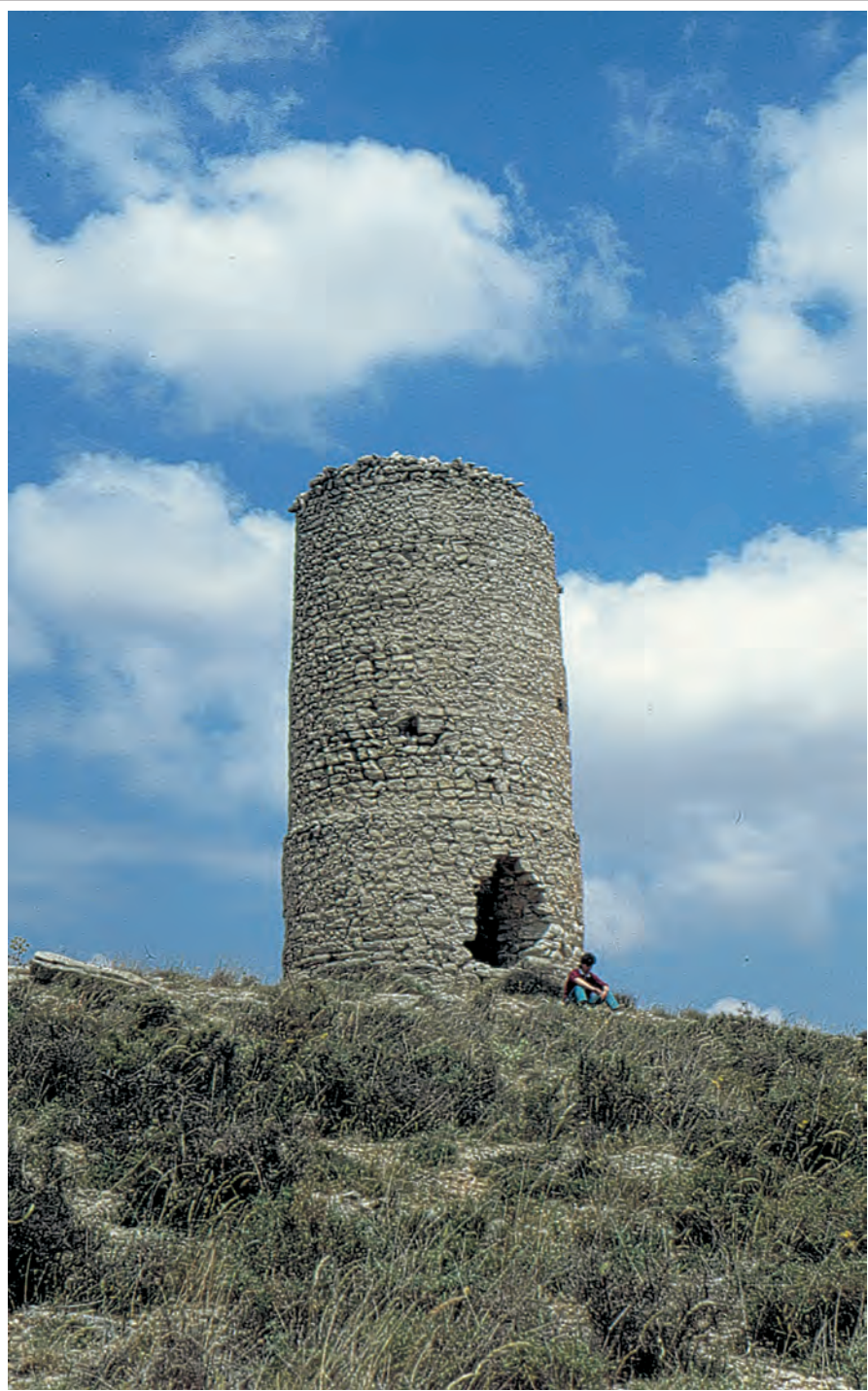
Atalaya construida por Almanzor el año 980, con medidas aproximadas de 6,35 metros en altura, 5,75 metros de circunferencia y 1,10 metros grosor del muro.
