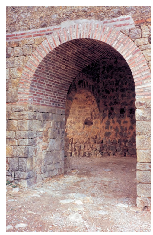
Puerta y arco de entrada (reconstruido) al alcázar de la fortaleza califal en Gormaz.
