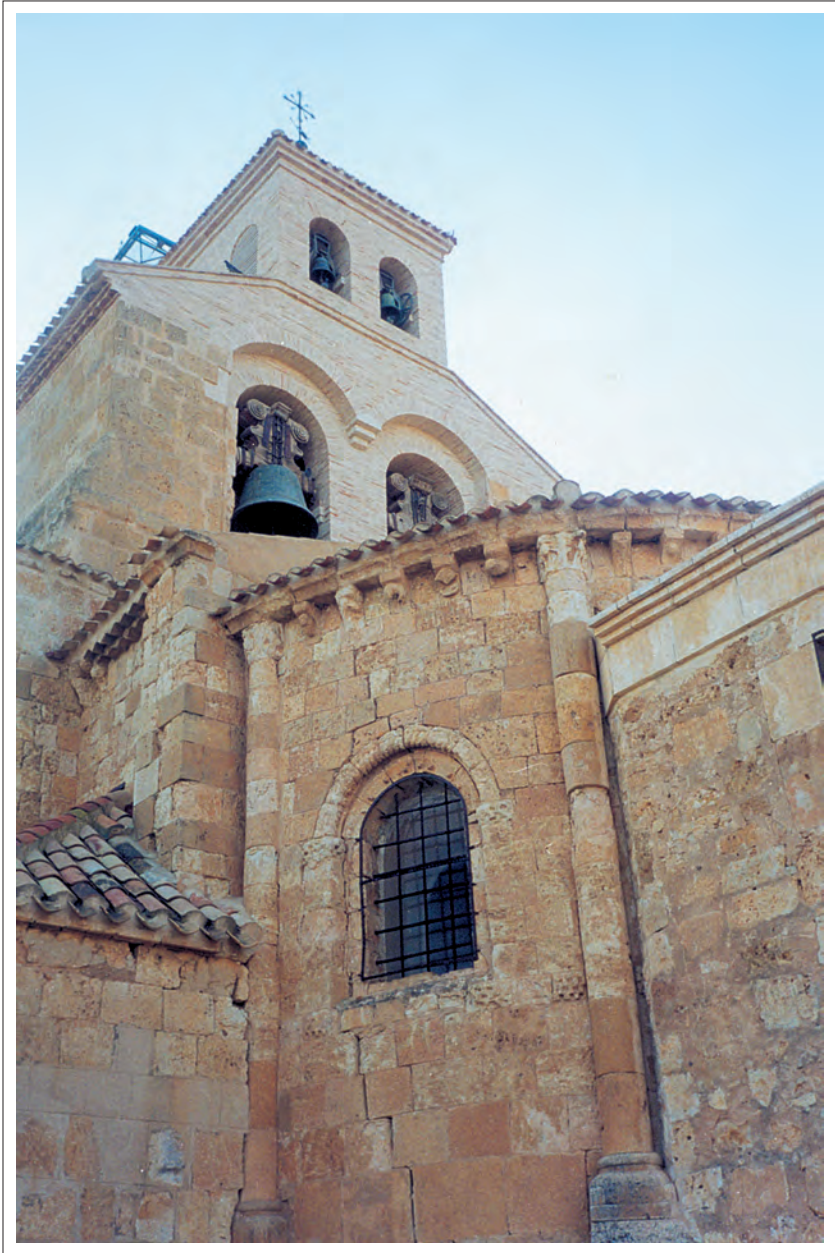
Iglesia románica de Santa María del Rivero del siglo XII (restaurada) en San Esteban de Gormaz, de nave única, ábside, galería porticada, campanarios y campo santo, templo modificado y ampliado en diversas épocas posteriores, en especial el campanario superior.
