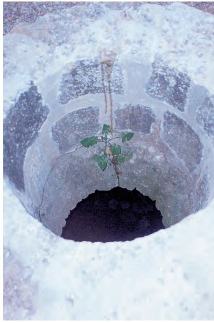
Boca de uno de los dos aljibes en el patio del alcázar en la fortaleza califal.
