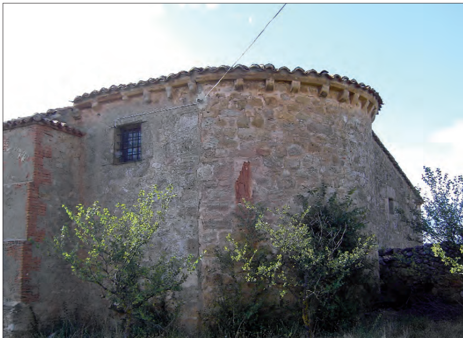
Ábside de la iglesia de La Ventosa
