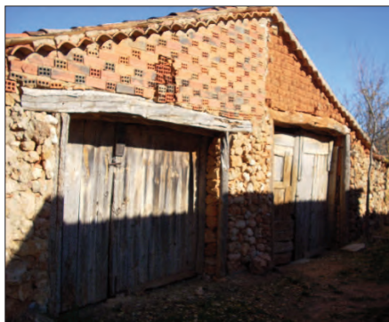
Todo se ha quedado ya vacío; antaño todo estaba lleno de vida. Los mozos y mozas trabajaban y gozaban, y lo llenaban todo.
