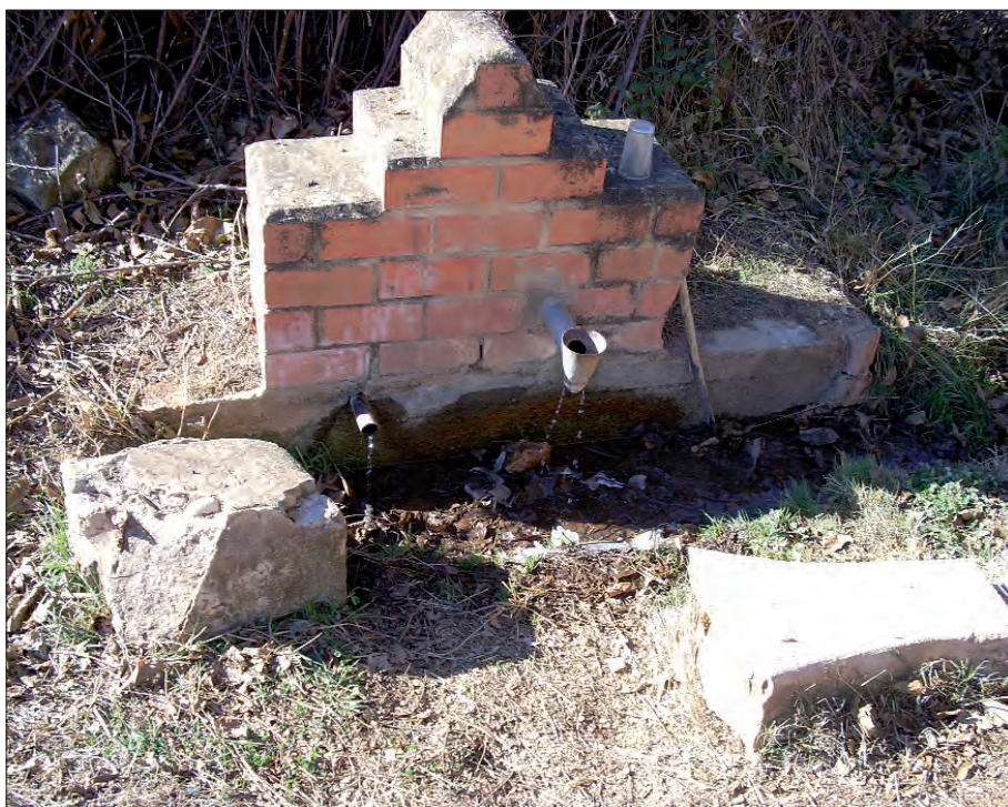
Sin “cenderas” todo se deterioró.
