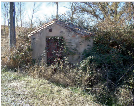
Aquí está el primitivo manantial que determinó el asentamiento de La Ventosa. Fue la fuente primera de La Ventosa, un pozo cubierto de una construcción de piedra, se entraba por una puerta y se llenaban los cántaros o botijas en una especie de charca de agua limpia y fresca. Fue sustituida por este chozo donde está el motor que sube hoy el agua al pueblo.
