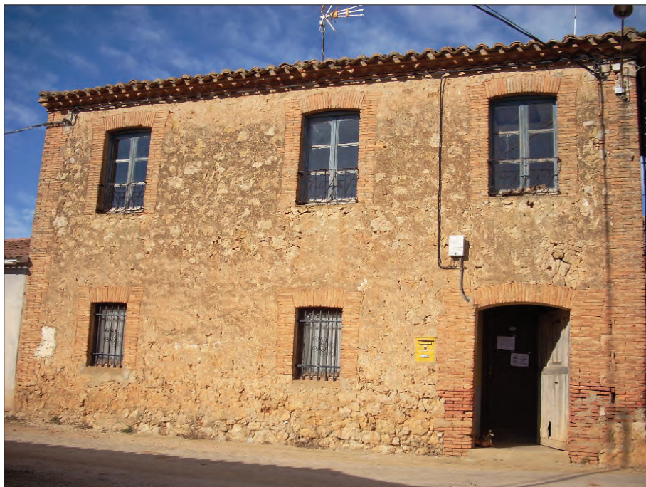
En el piso superior estaba la escuela, abajo el Ayuntamiento.
