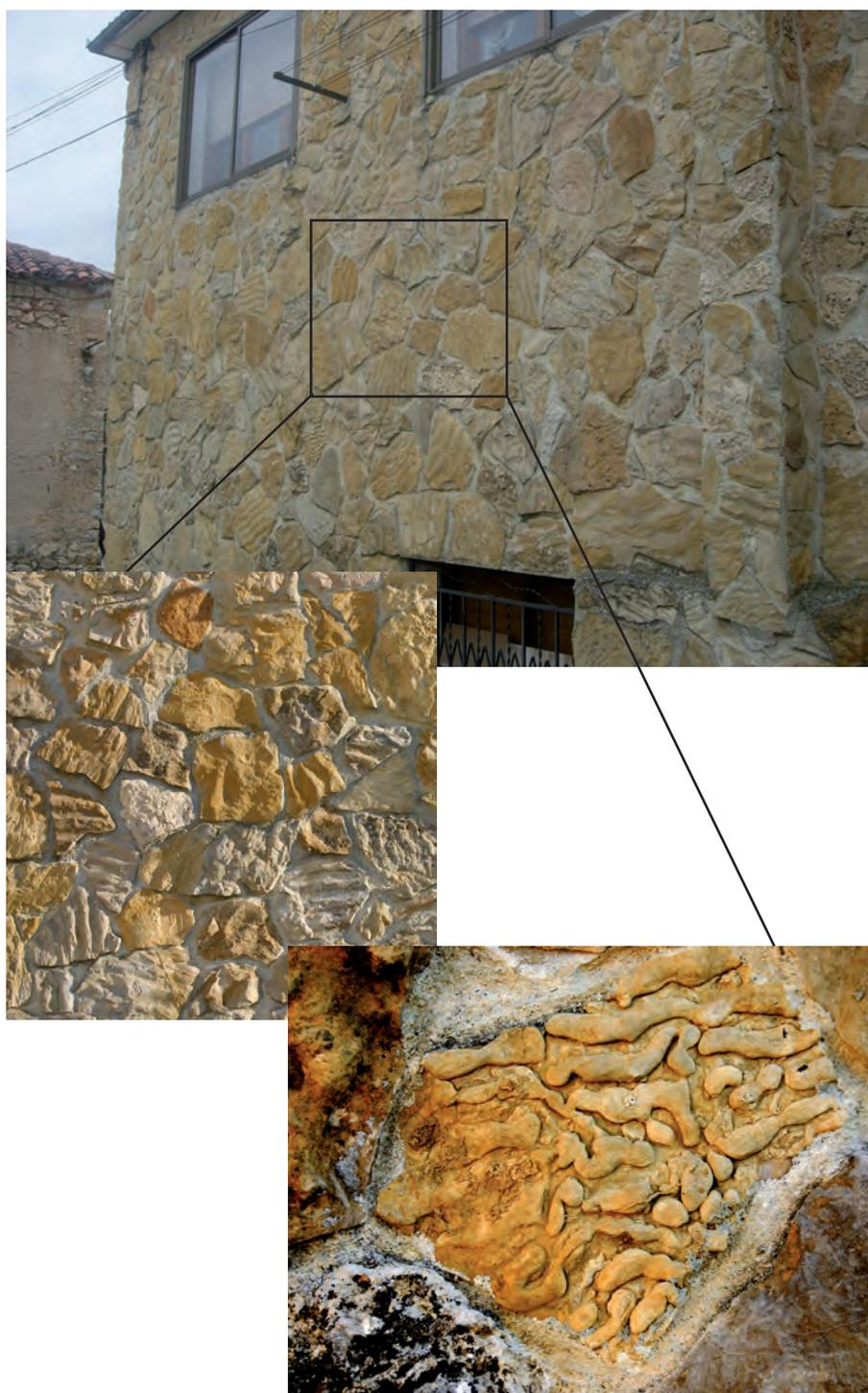
Figura 2.13. La Casa de las olas de piedra de Casarejos. Las fachadas de la casa están revestidas con placas de laminas de estratos del Garumnense que presentan numerosas estructuras sedimentarias. Foto de enmedio, rizaduras de oleaje; foto de abajo, bioturbación.
