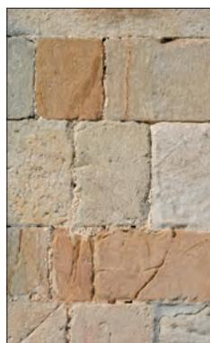
Figura 1.10. Las areniscas de la Facies Weald se han empleado para los sillares de las construcciones de los pueblos del entorno. Ermita de La Virgen de La Blanca (Foto T. Torroba)
