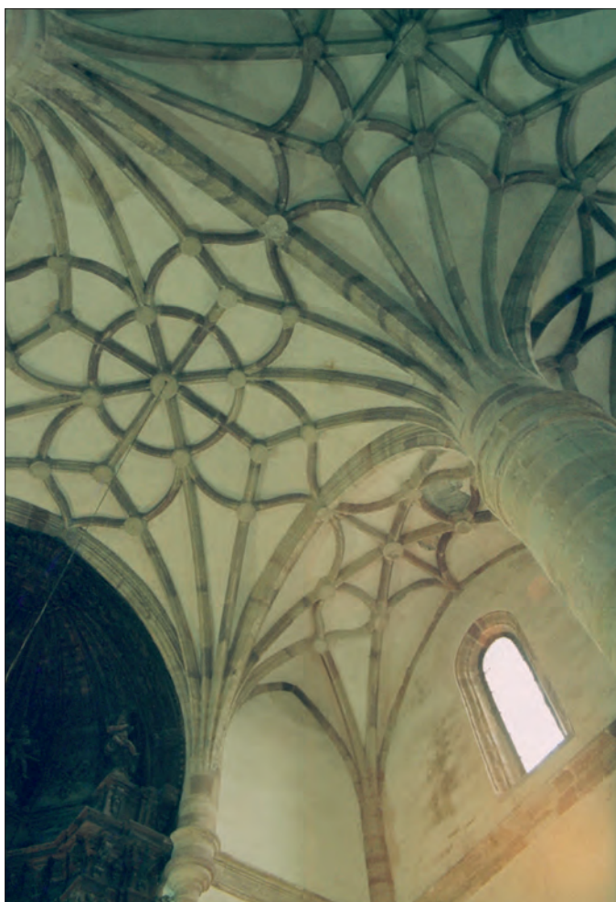
Bóvedas de la Iglesia de Retortillo, levantada por los Torres.
