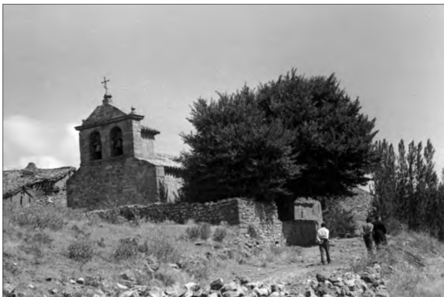
Iglesia de Cañicera antes de su derrumbre en los años 80.
