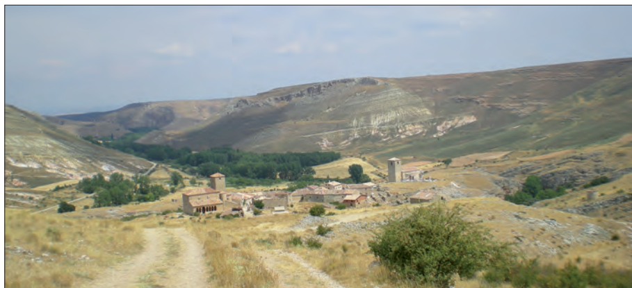
Vista general de la villa de Caracena.
