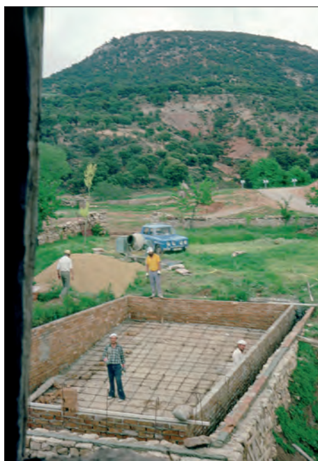
Construcción de una piscina.
