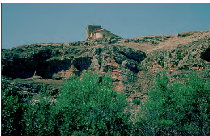
La Iglesia de Santa María, desde el río, en lo alto de la plataforma rocosa donde se alza la Villa.
