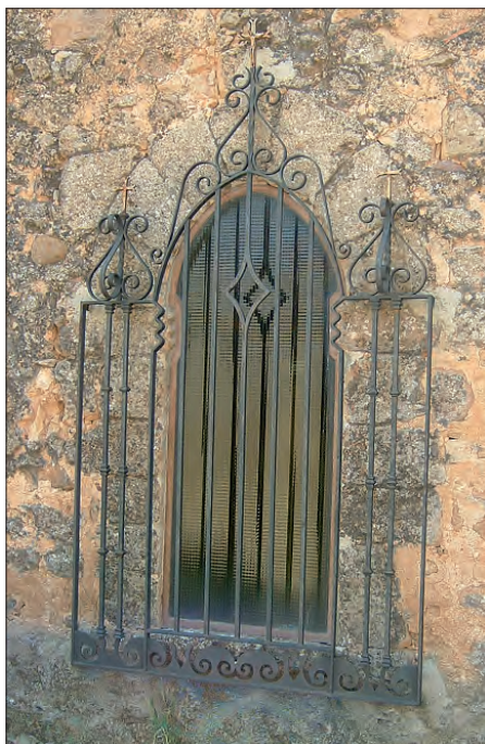
Puerta de arco apuntado en el muro norte.
