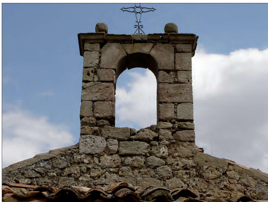
Espadaña de la ermita donde se encontraba el campanillo
