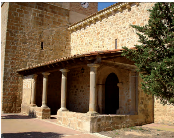
Portal de entrada a la iglesia en un segundo piso estaba el granero
