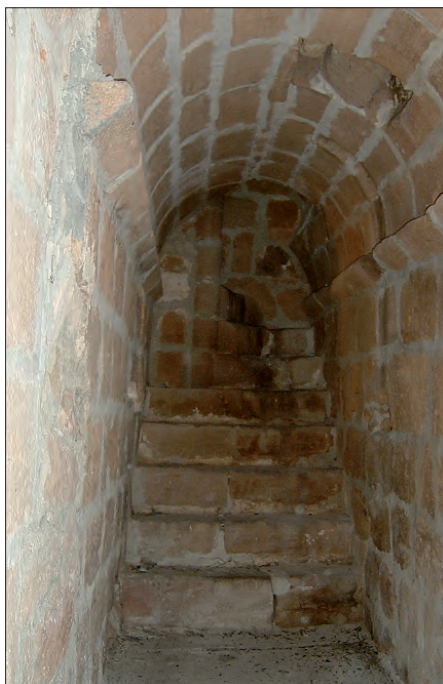
Bóveda de cañón y escaleras de acceso a la torre.
