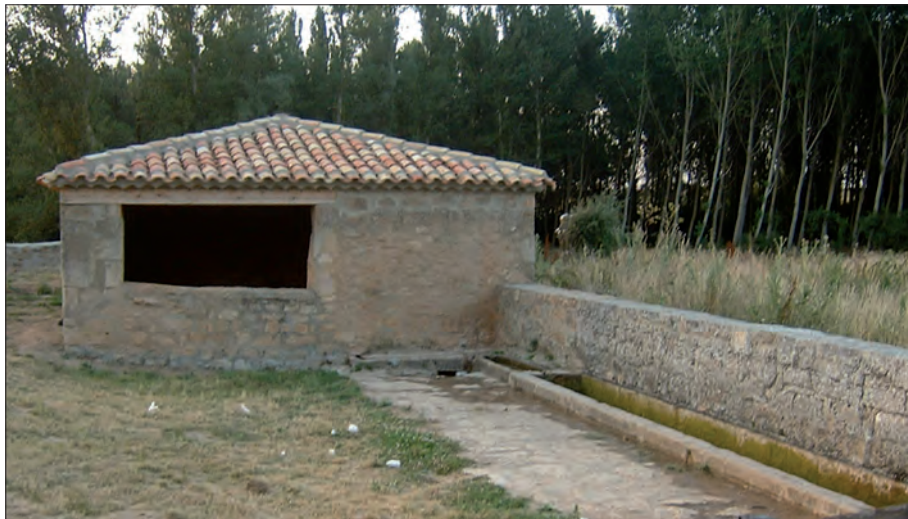
Lavadero y abrevadero recientemente restaurados
