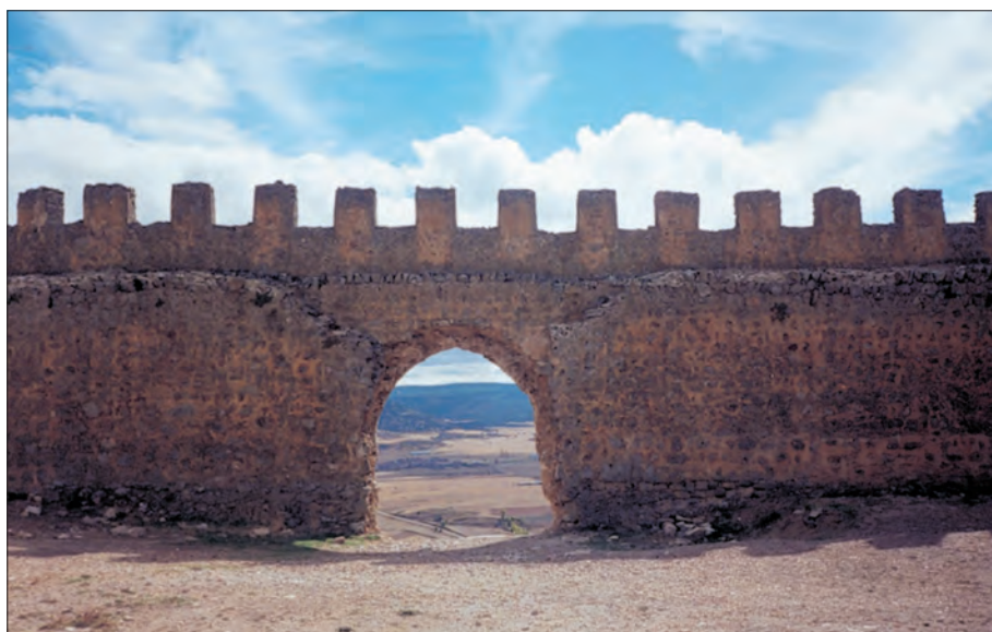
Actual puerta de entrada al albacar de la fortaleza califal, abierta por rasgadura del muro almenado junto a la poterna número 19
