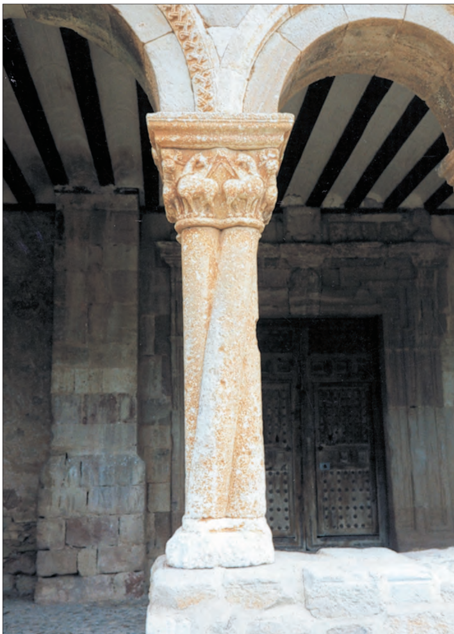
Columnata con labrados inclinados entrada principal al claustro parte sur
