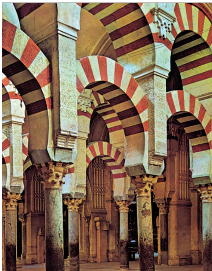
Policromía de arcos combinados con ladrillo rojo y piedra blanca. Las columnas son de mármol policromado y los capiteles, también de mármol, presentan distintas formas.
