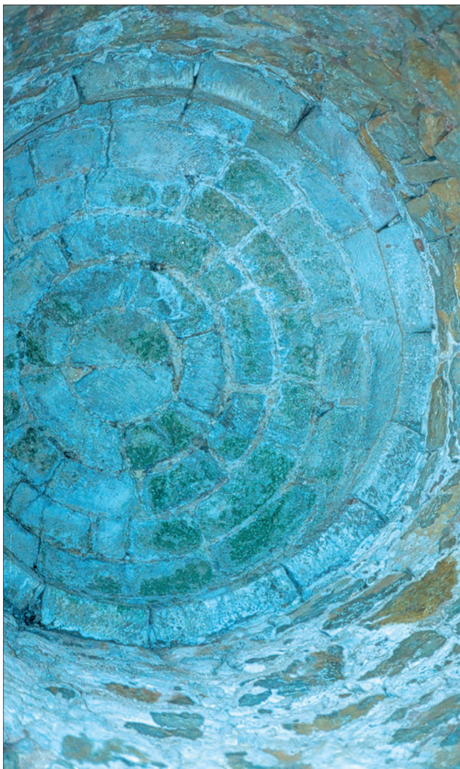
Embovedado de la arpillera o garitón para armas de fuego en la parte externa del castillo construida en el siglo XV
