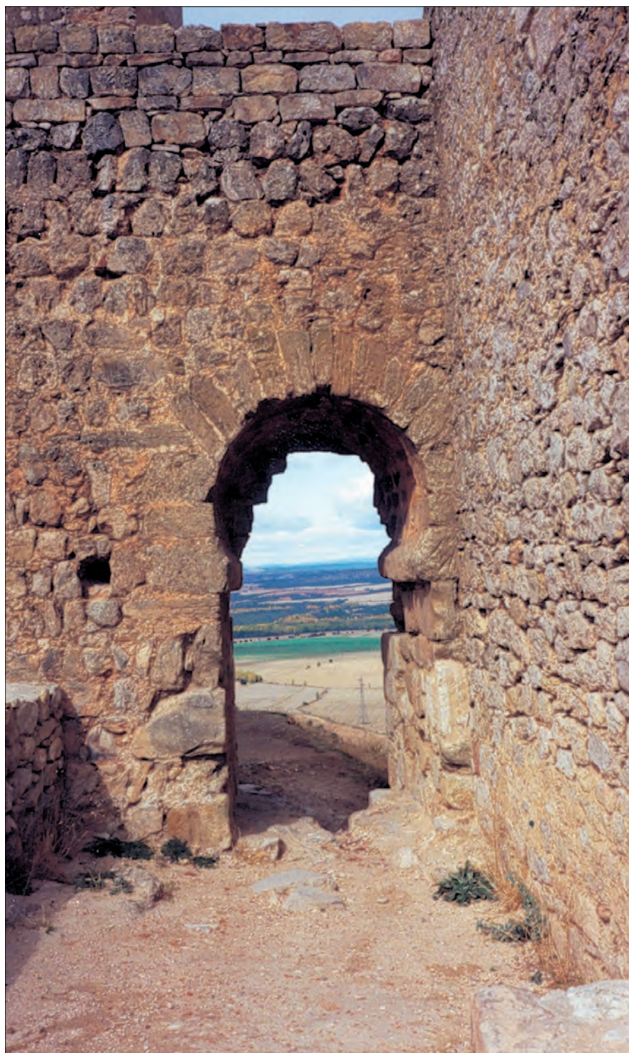
Puerta de escape de construcción árabe en la parte norte del alcázar en la fortaleza califal de Gormaz
