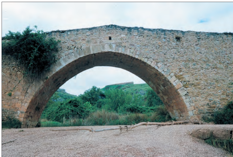
Vista del arco del puente romano-medieval sobre el río Caracena en la villa
