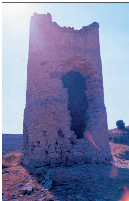
Parte este de la atalaya donde se encuentra el estrecho acceso situado sobre 1,20 metros de altura
