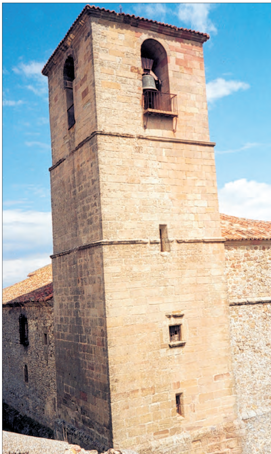
Torre del campanario de una iglesia en la villa de Atienza
