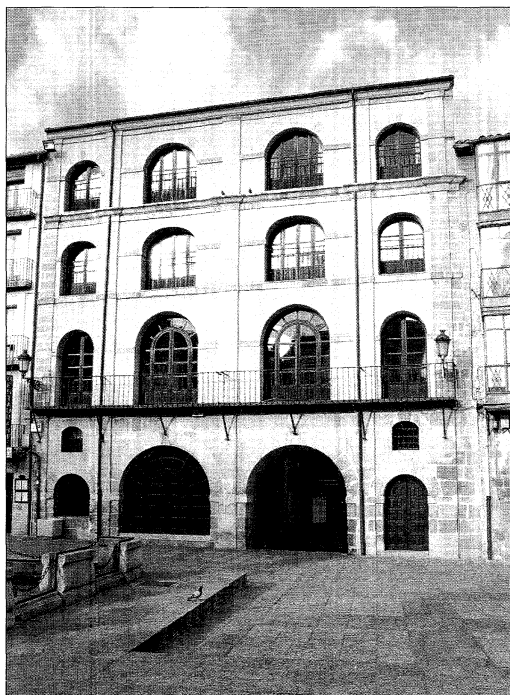
Casa del Común en la plaza Mayor, recientemente restaurada.
