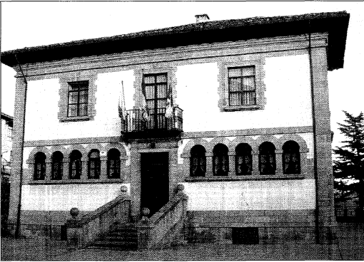
Colegio público Manuel Blasco, fachadas Sur y Oeste.
