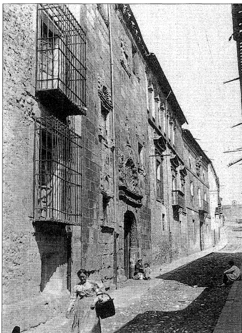
Calle Aduana Vieja. Al fondo, en la actual calle de Santo Tomás, se divisa el primitivo Hospital de Santa Isabel.
