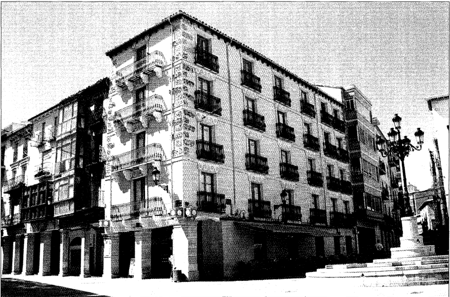
Andrés de Lorenzo. Casa de Fermín Jodra. Estado actual.
