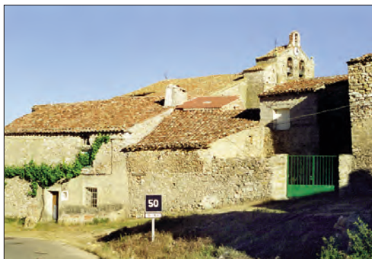
Vista iglesia Pradillo
