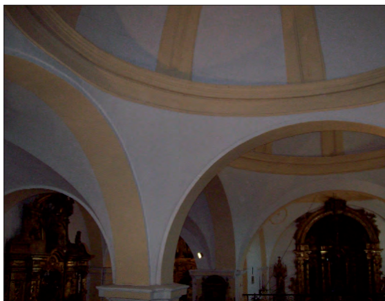
Bóvedas, interior de la iglesia
