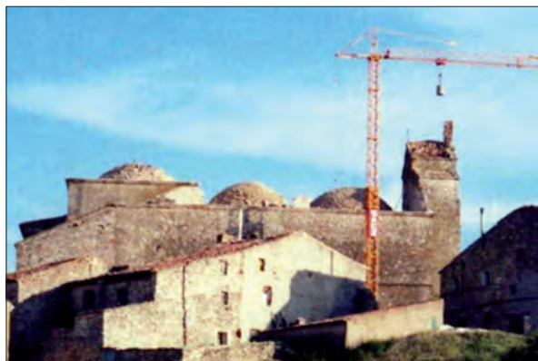
Bóvedas de la iglesia-obras
